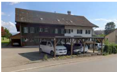
Nr. 12: Ansicht von Norden (Google Maps)
