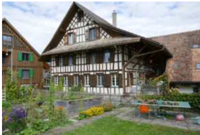
Nr. 13: Ansicht von Westen (Bild SKW)
