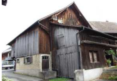
Nr. 4: Südseitiger Anbau zur Ökonomiebaute Rifferswilerstrasse 1 (Bild: SKW)
