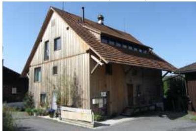
Beispiel eines schmalen Dachabsatzes (alte Kappelerstrasse 2, Uerzlikon)
