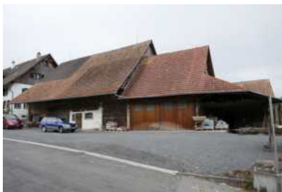
Nr. 4: Ansicht von Westen (Bild SKW)
