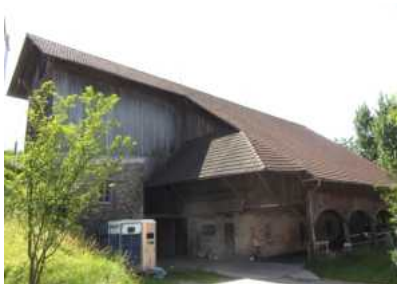
Ansicht von Norden (Bild SKW)
