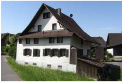
Nr. 1: Ansicht von Nordosten (Bild SKW)
