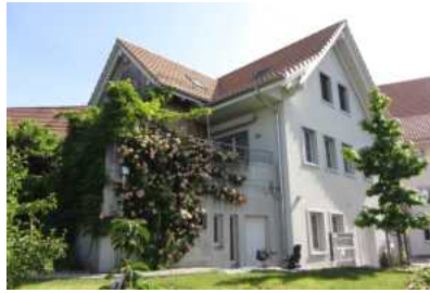
Näfenhüser 7a, Ansicht von Nordost (Bild SKW)
