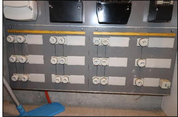
Abbildung 1: Hauptverteilung (Sicherungskasten)
